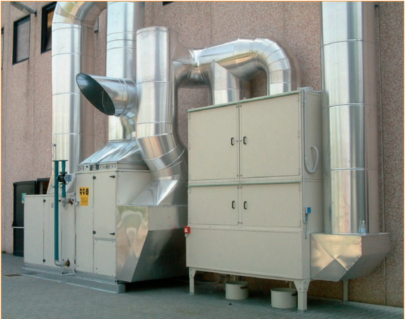
Installation avec récupération d'énergie
