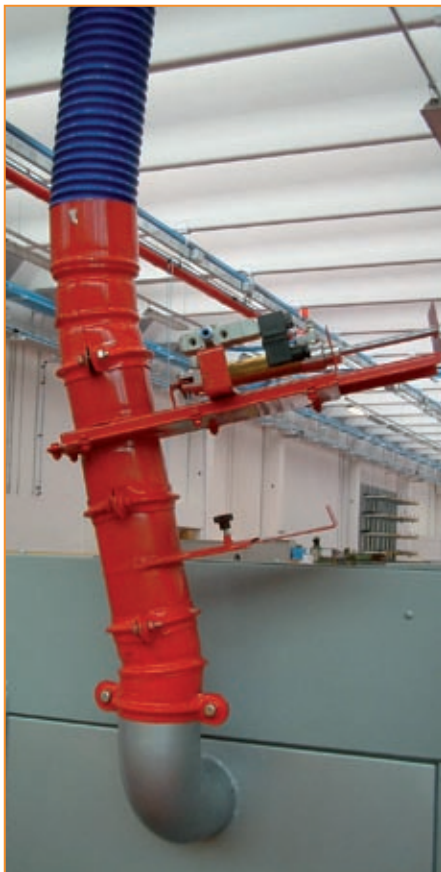
Prise aspirante avec clapet de réglage, clapet on/off électro-pneumatique et 'emboîtement' anti-huile
