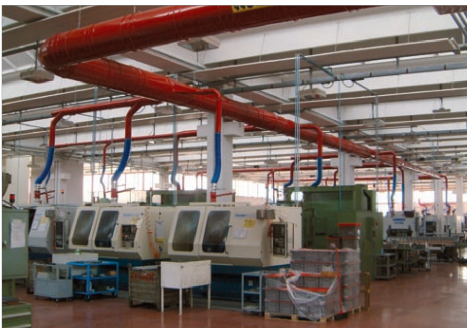
Installation de captation brouillards d'huile dans une usine de production menuiserie métallique pour le secteur de l'automobile
