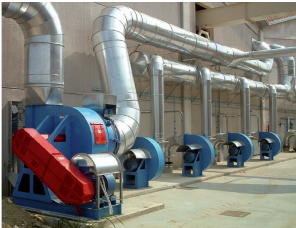
Ventilateur avec accouplement transmission
