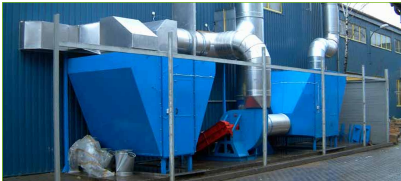
Esecuzione speciale di Aisol HZ con reintegro in ambiente per recupero energetico
