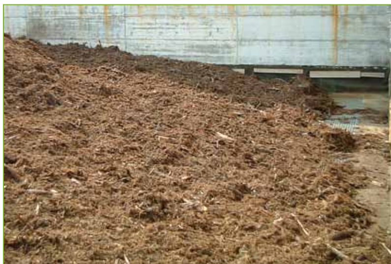
Biofiltro in fase di riempimento
